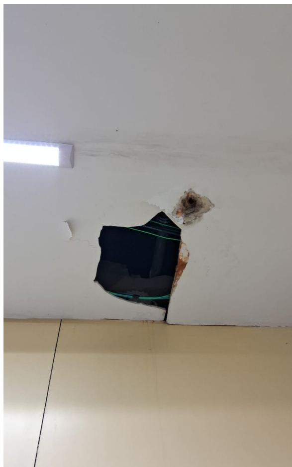
Local reparo do gesso da cozinha (item 3)
