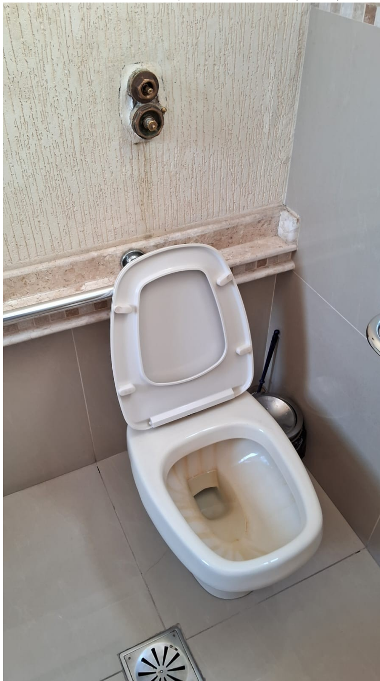
Local instalação vaso sanitário (item 4)
